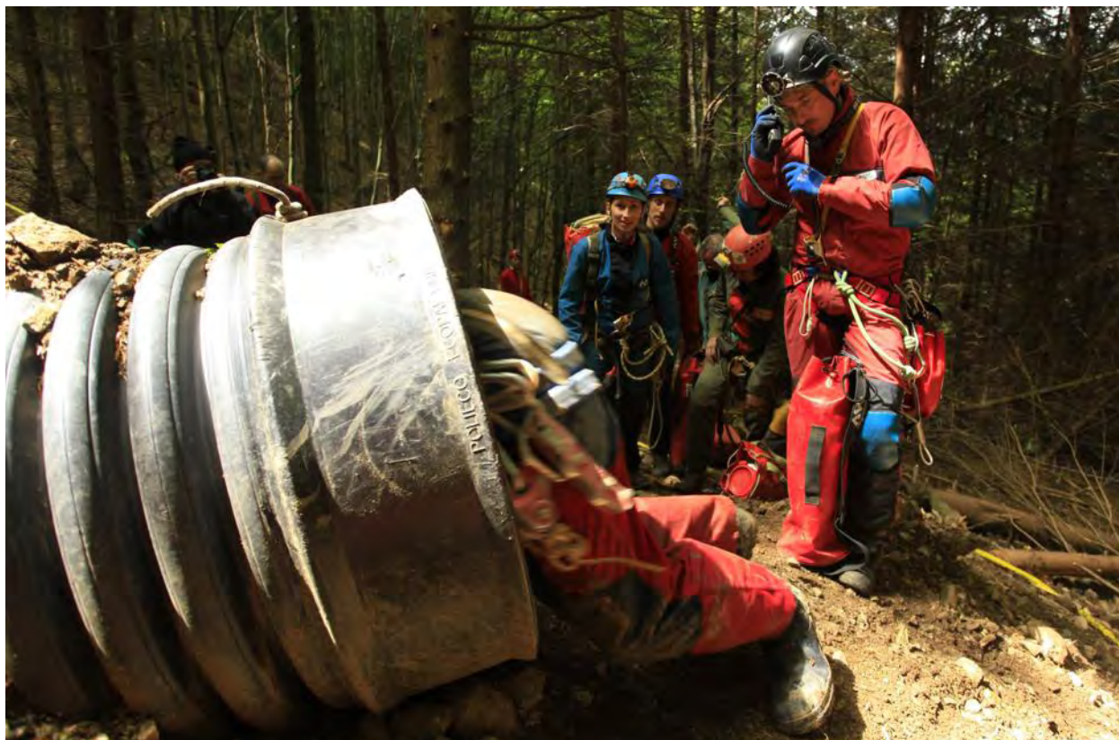
Les premières équipes s'aventurent dans le boyau qui mène à l'entrée de la mine. PHOTOS DNA – JEAN-FRANCOIS OTT
