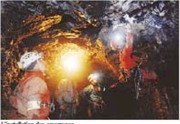
L'installation des amarres.
